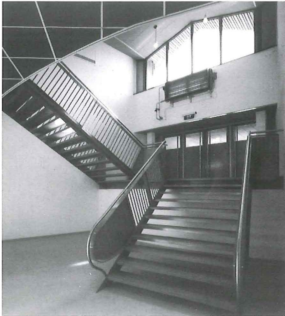
Na de verbouwing
